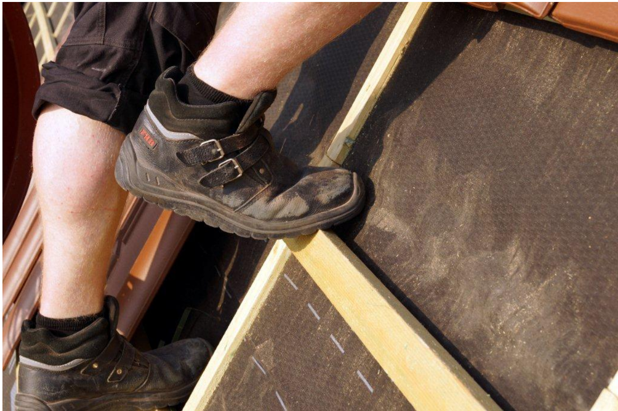
Abb. 1: Dachunterspannbahnen auf dem Dach
